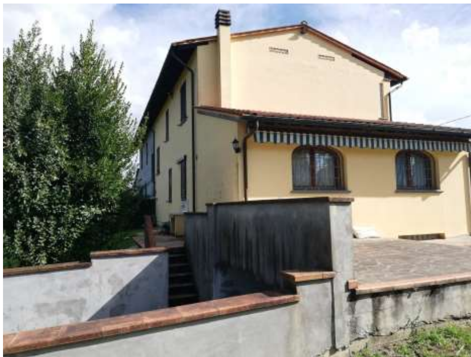
FOTO N° 4 – rampa accesso alla cantina
