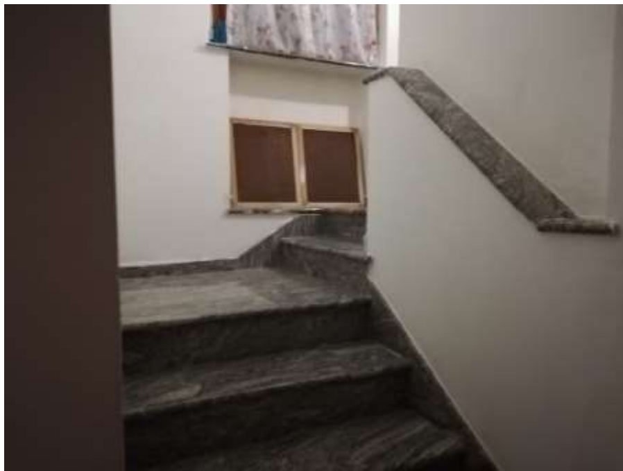
FOTO N° 15 - Scale accesso piano primo
